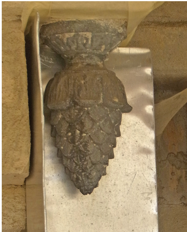
Abb. 12 A_Strahlen_1.JPG Pinienzapfen, Zinkguss, Schutzmaßnahme für Bearbeitung in situ, abgeschlossene Maßnahme Gebäudebereich SOP
