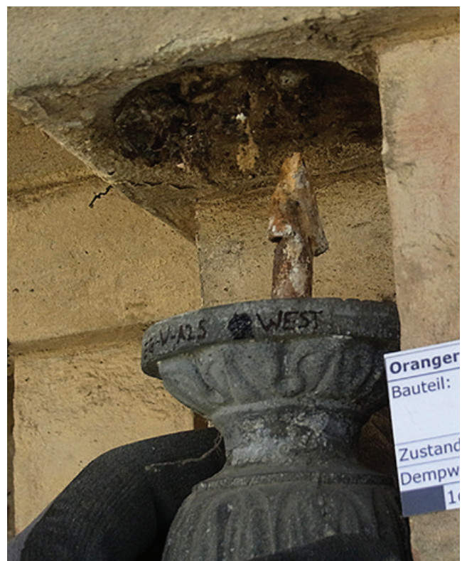
Abb. 15 A5.JPG Pinienzapfen, Zinkguss, mit Maueranker Bestandsversion 2
