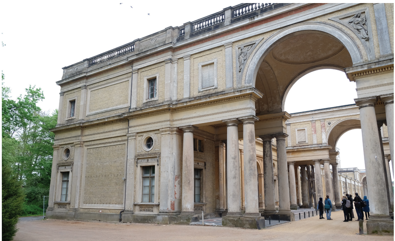
Abb. 08 2019-04-29 FB_048 OR.JPG Nord-West-Pavillon & WV Bestand - Westfassade, DG nahezu baugleich mit Nord-Ost-Pavillon & OVL
