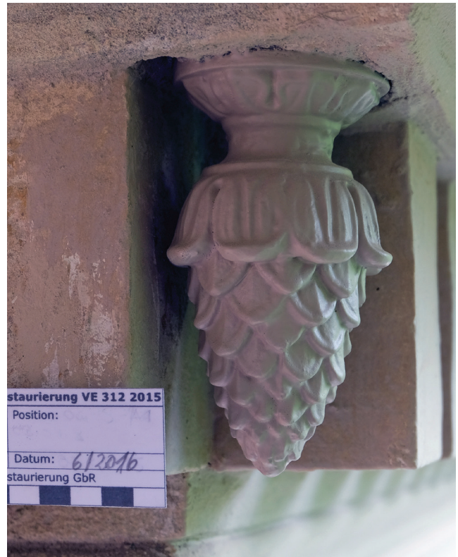
Abb. 14 <Keine überschneidende Verknüpfung> Pinienzapfen, Zinkguss, Endzustand, abge- schlossene Maßnahme Gebäudebereich SOP
