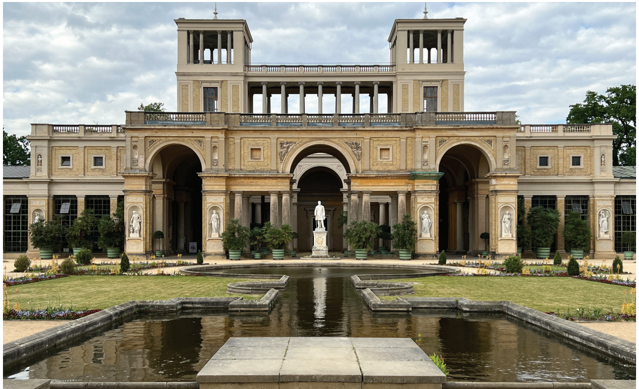
Abb. 03 2024-05-16 FEB_339 OR.JPG Mittelbau Südfassade
