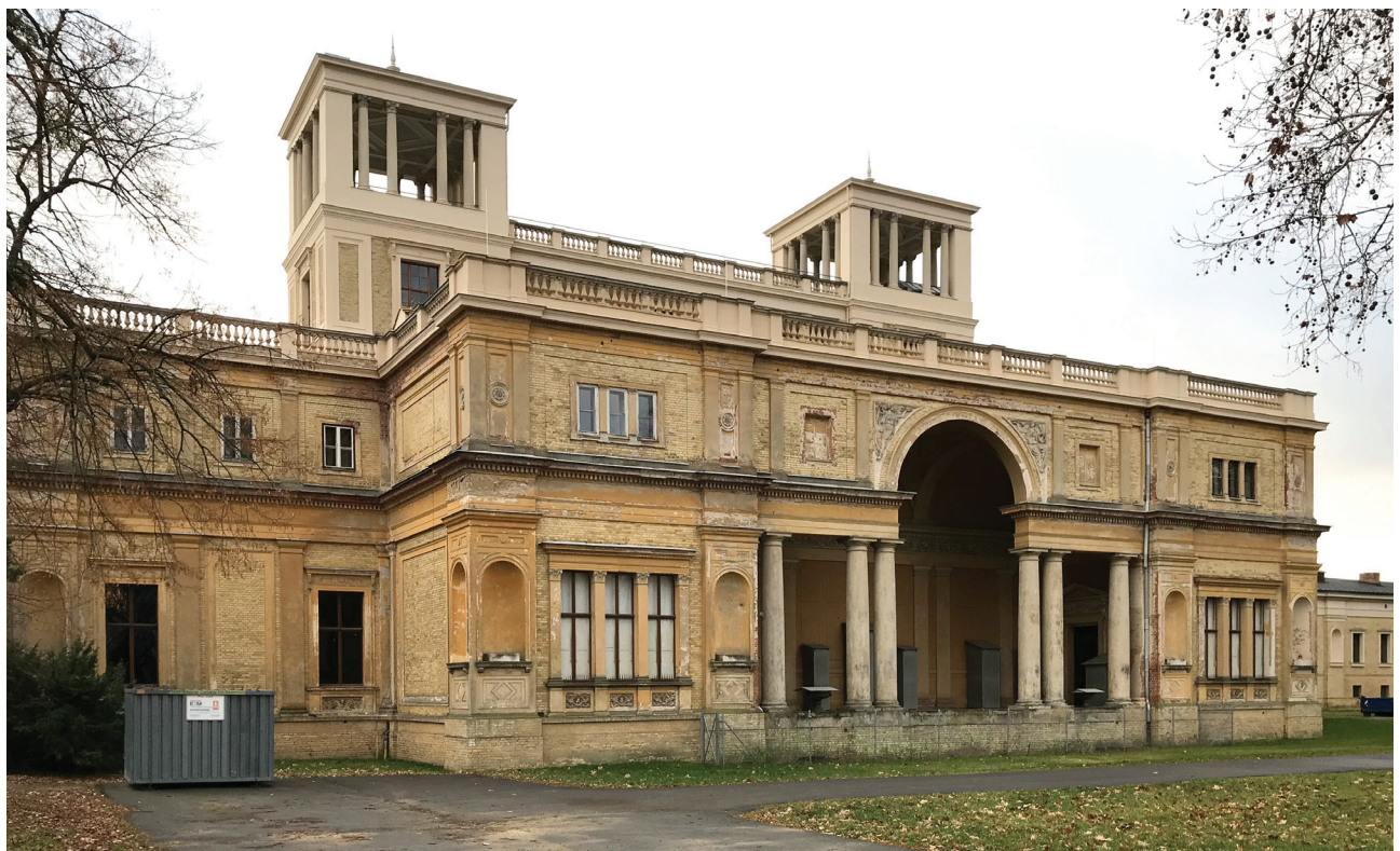
Abb. 04 2020-01-19 ML_003 OR.JPG Mittelbau-Nord Nordfassade - mit Nordloggia, Balustrade bereits saniert
