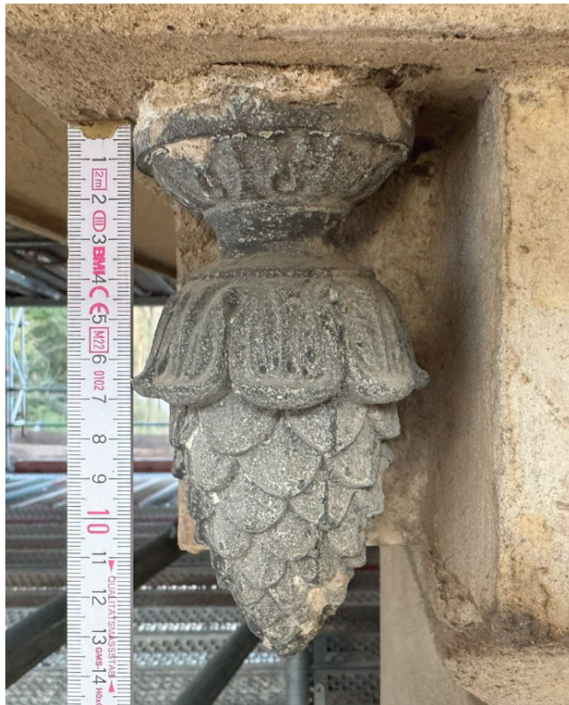
Abb. 09 Pinienzapfen.JPG Pinienzapfen, Zinkguss, in situ OVL
